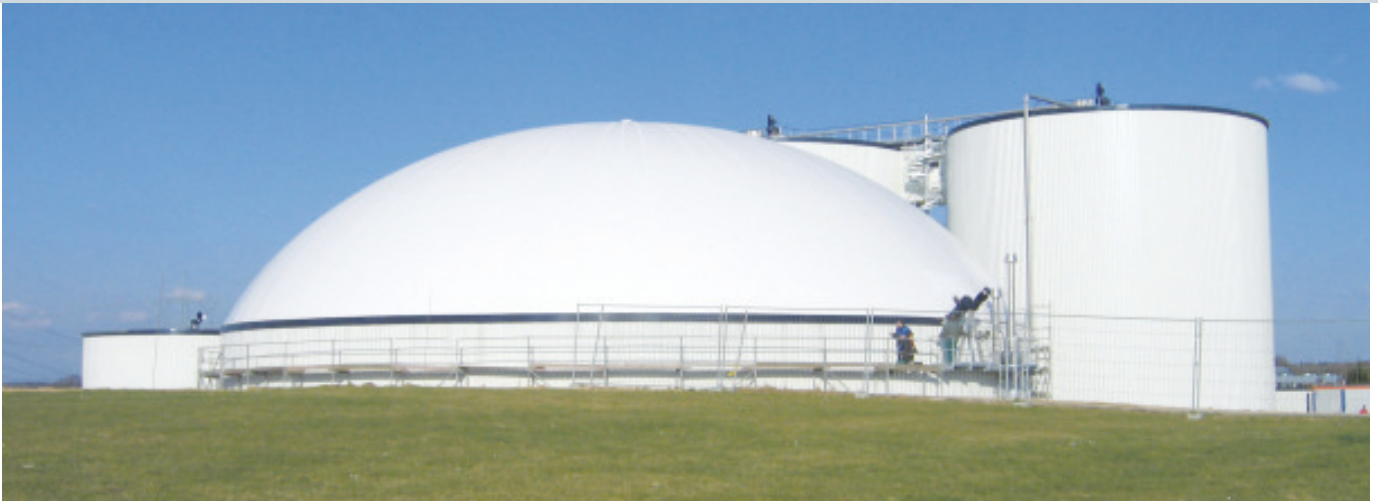
Bild 1: Ansicht der Speiserestvergärungsanlage Malchin mit kombiniertem Gärrest-Gaslager und CSTR-Fermentoren.
