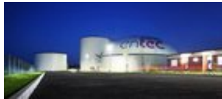
Eine der vielen „entec“-Kraftwerke rund um den Erdball. Im Bild die Anlage in Malchin in Deutschland. (Quelle: entec)
